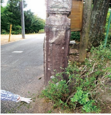
高屋西小学校の南側の門
